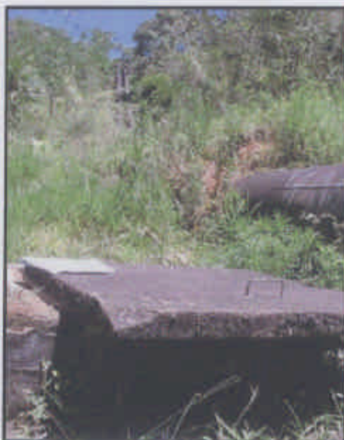
Foto 65: Caixa receptora da água de mina utilizada na área da Vila.
