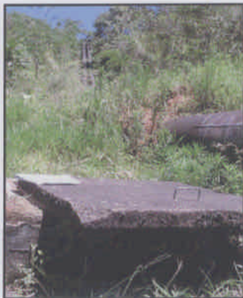
Foto 03: Caixa de passagem que recebe a água da mina para abastecimento da Casa de Força e Vila Residencial da PCH São Bernardo. Fonte: PENIDO, F. C. 2006
