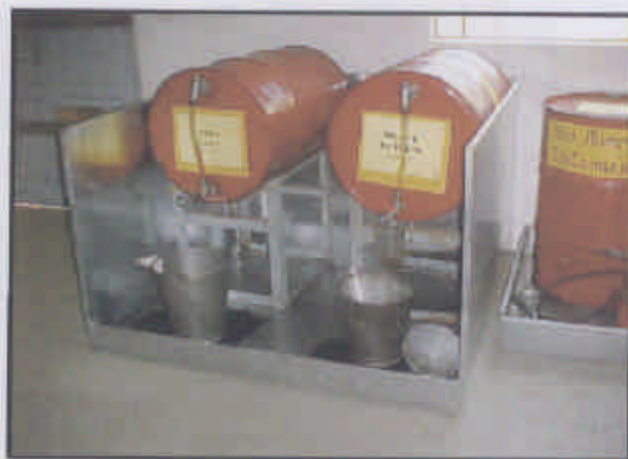
Foto 62: Tambores de óleo dispostos dentro de bacias metálicas para não contaminar o solo. Fonte: PENIDO, F.C. 2006
