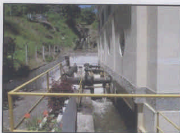
Foto 12: Chegada dos condutos forçados na casa de força. Fonte: PENIDO, F. C. 2006.
