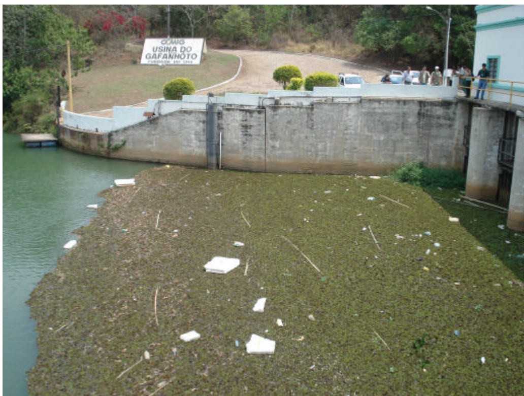
Foto 3 – Detalhes do reservatório da PCH Gafanhoto onde se pode observar uma grande quantidade de macrófitas aquáticas e lixo.
