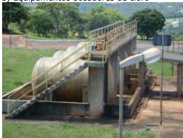
b) Equipamentos dosadores de cloro
