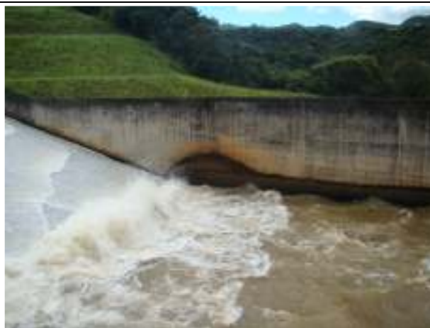
b) Ressalto da descarga do vertedouro
