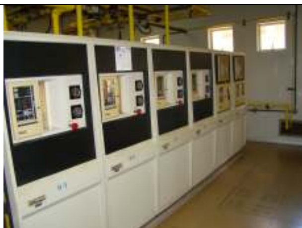
b) Equipamentos dosadores de cloro
