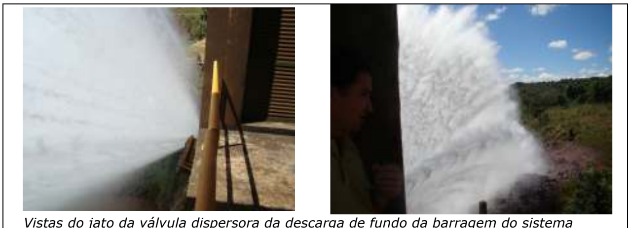
Figura 9: Válvula Dispersora na Descarga da Barragem
