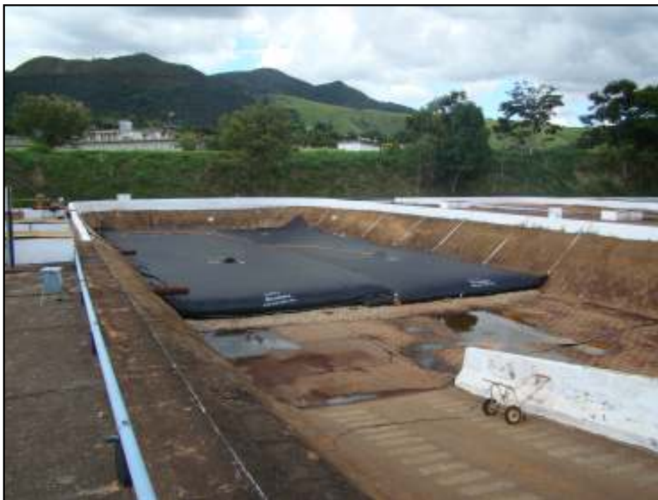
Figura 5: Desidratação do Lodo em Sacos Geotéxteis
