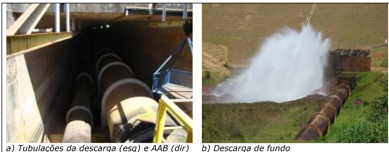
Figura 44: Descarga de Fundo da Barragem do Sistema Rio Manso
