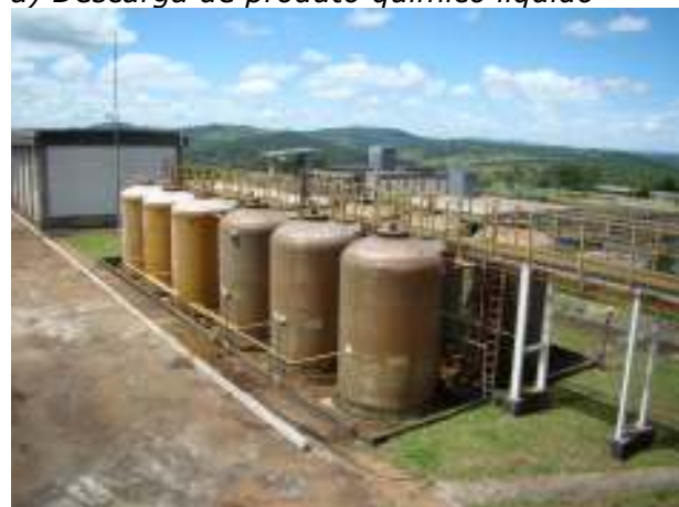
c) Tanques de armazenagem dos produtos líquidos
