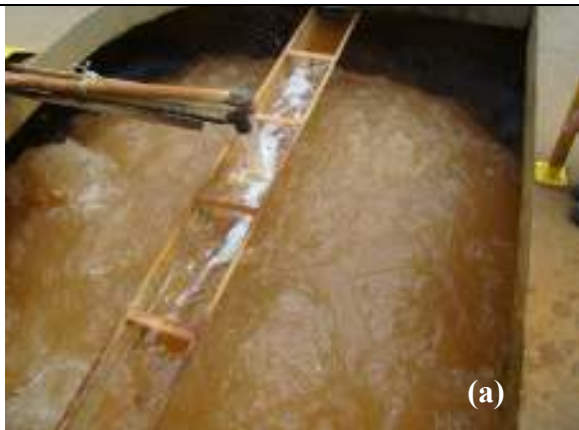
Detalhe do vertedor tipo tulipa em operação (a) e paralisado (b)
