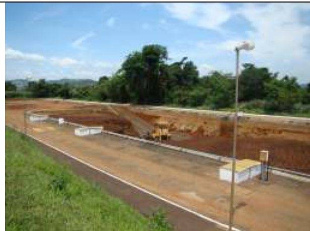
a) Remoção do lodo de lagoa de desidratação
