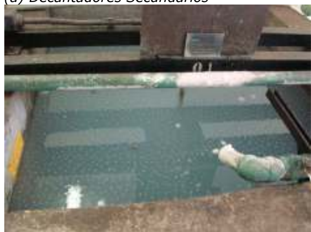
(c) Tanque de preparo de polieletrólito
