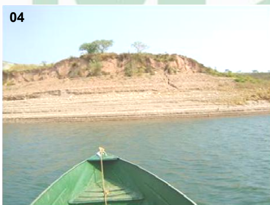
Figura 04- Ponto localizado nas proximidades da ponte da rodovia BR 462, na margem esquerda do reservatório e Município de Perdizes. Atualmente está estabilizada, mas existem riscos de novos desmoronamentos, quando o reservatório atingir sua cota máxima, e o embate das ondas provocarem deslizamentos do talude. Figura 05- Localizada na margem esquerda
