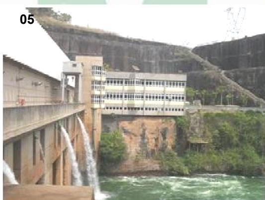
Figura 05- Saída de água do resfriamento das máquinas e ao fundo escritório; Figura 06- Saída de água após passar pelo gerador. Fonte: Manna & Toledo, 2011.
