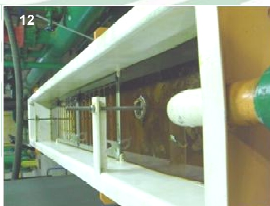
Figura 11 – Vista dos Geradores Hidrelétricos; Figura 12- Caixa separadora de água e óleo interna. Fonte: Manna & Toledo, 2011.
