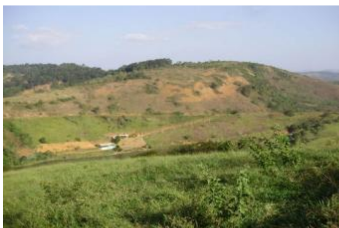
Foto 21 - CBA – Barragem de rejeito.
