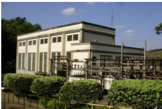
Foto 1 - Casa de Força.
