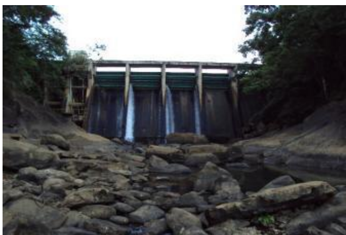
Foto 141 - Foto da barragem da PCH Nova Maurício tirada à jusante da mesma durante as campanhas de amostragem do monitoramento de 2010
