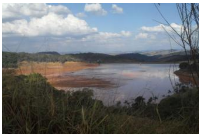
Foto 19 - CBA – Barragem de rejeito.
