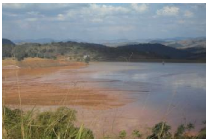
Foto 20 - Barragem a montante do reservatório.
