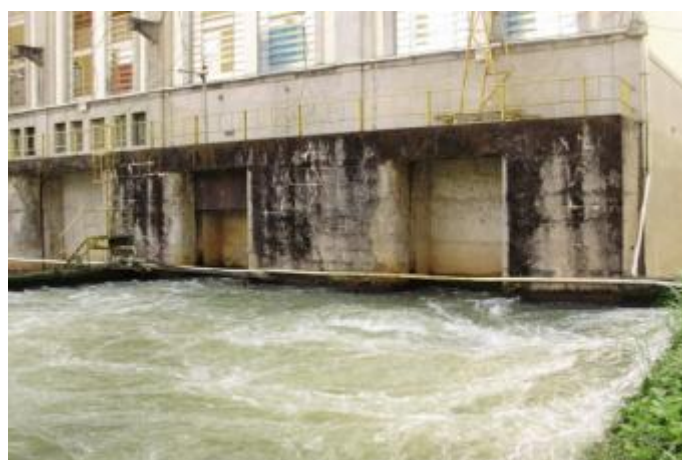
Foto 8 - Água após passar pelas turbinas.
